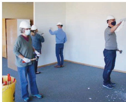
Spatenstich durch die Baukommission.
